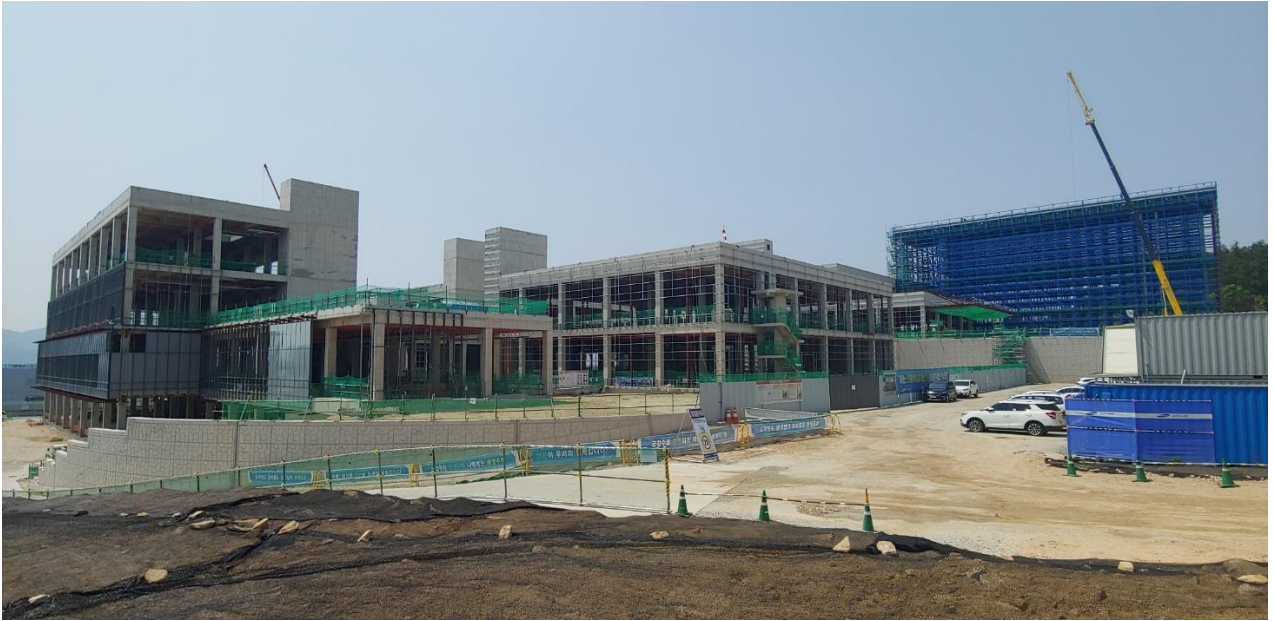
(이연제약 충주공장 건설현장 촬영모습 - 정면)
