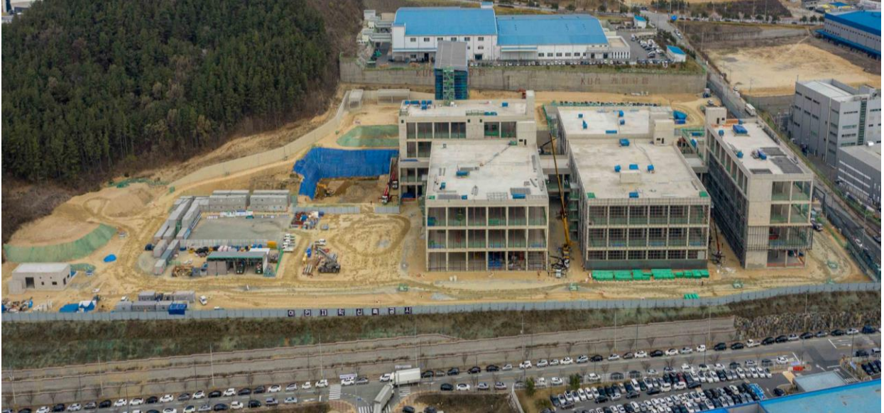
(이연제약 총주공장 건설현장 드론 촬영모습 - 정면)
